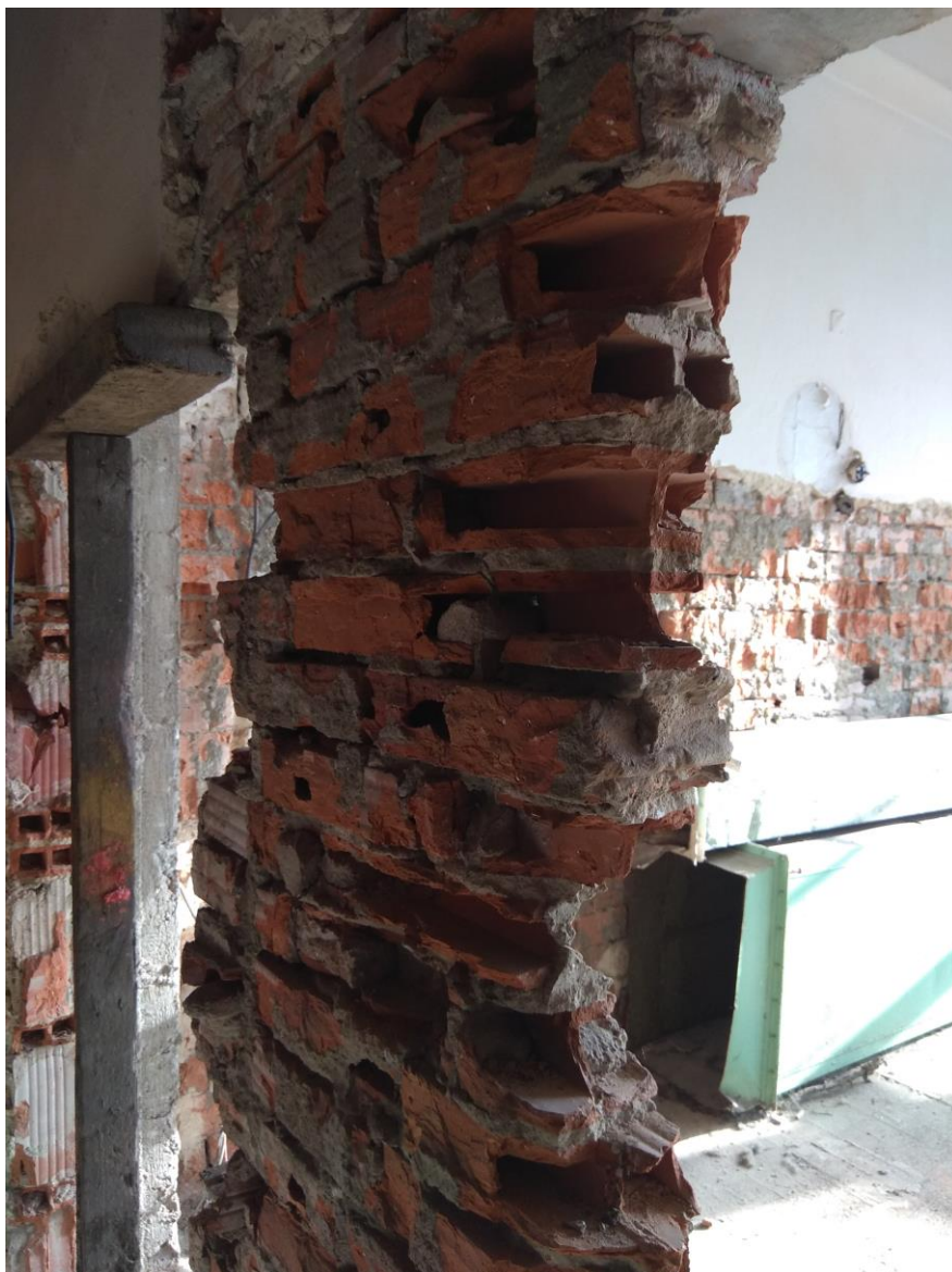
obr. č. 14 – detail odbourání příčky na cihelný pilíř
