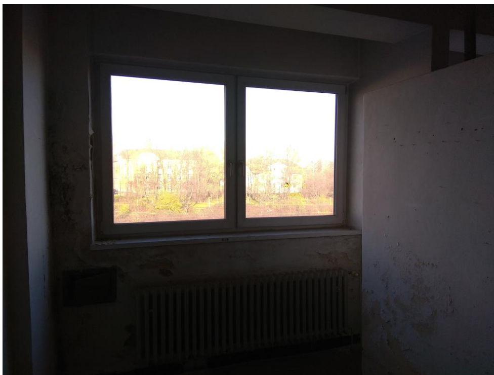
obr. č. 16 – pohled parapetní zdivo a příčnou stěnu – mapy od vlhkosti
