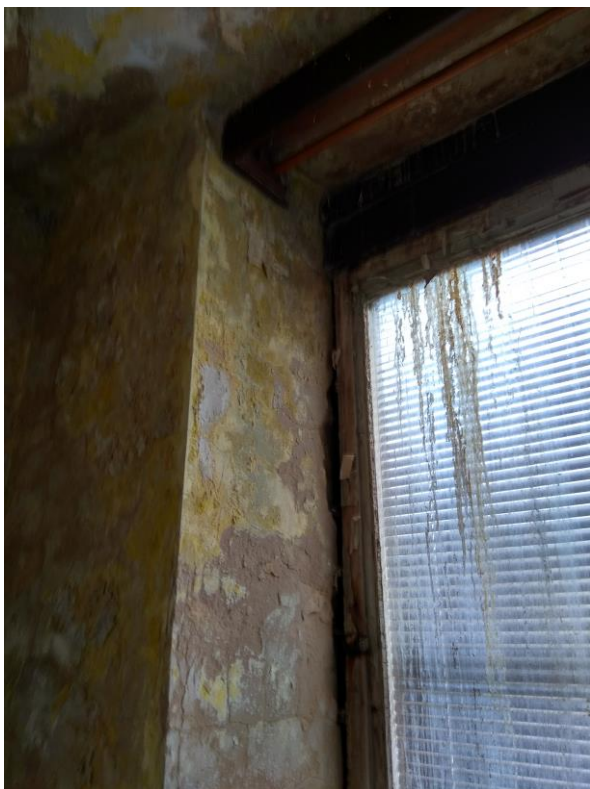
obr. č. 7 – pohled na ostění a nadpraží poškozené od zatékání
