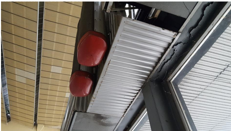
obr. č. 9 – ocelová konstrukce s poškozeným nátěrem
