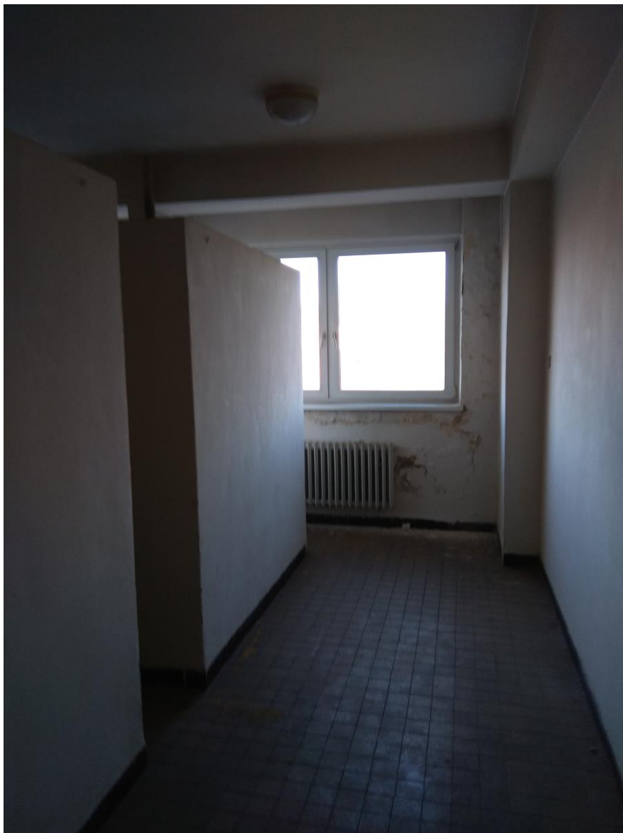
obr. č. 17 – pohled parapetní zdivo a ostění – mapy od vlhkosti
