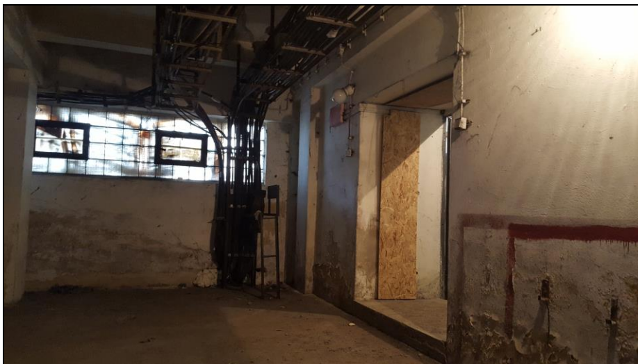
obr. č. 2 – pohled na zdivo suterénu, mapy po vzlínání vlhkosti
