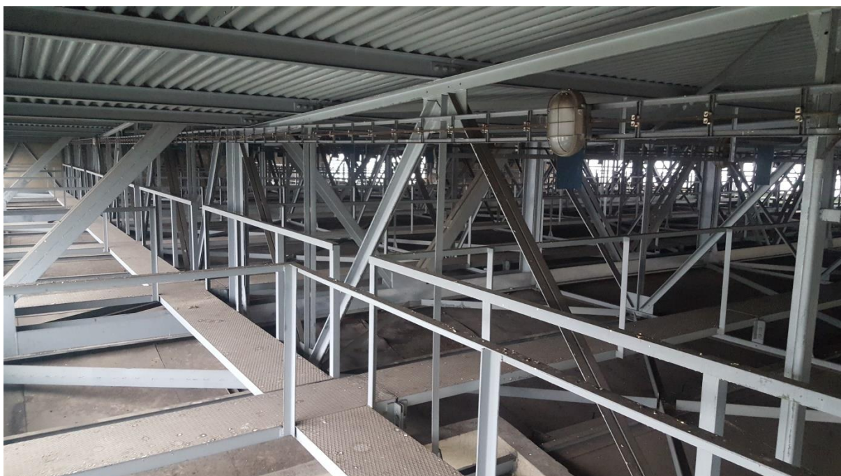
obr. č. 18 – pohled na mezistřešní prostor – ocelové příhradové vazníky
