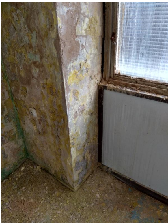
obr. č. 8 – pohled na ostění a nadpraží poškozené od zatékání
