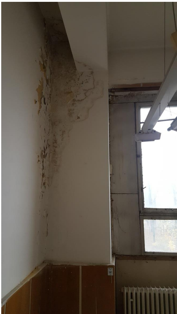
obr. č. 11 – pohled na lokální místo poškozené zatečením
