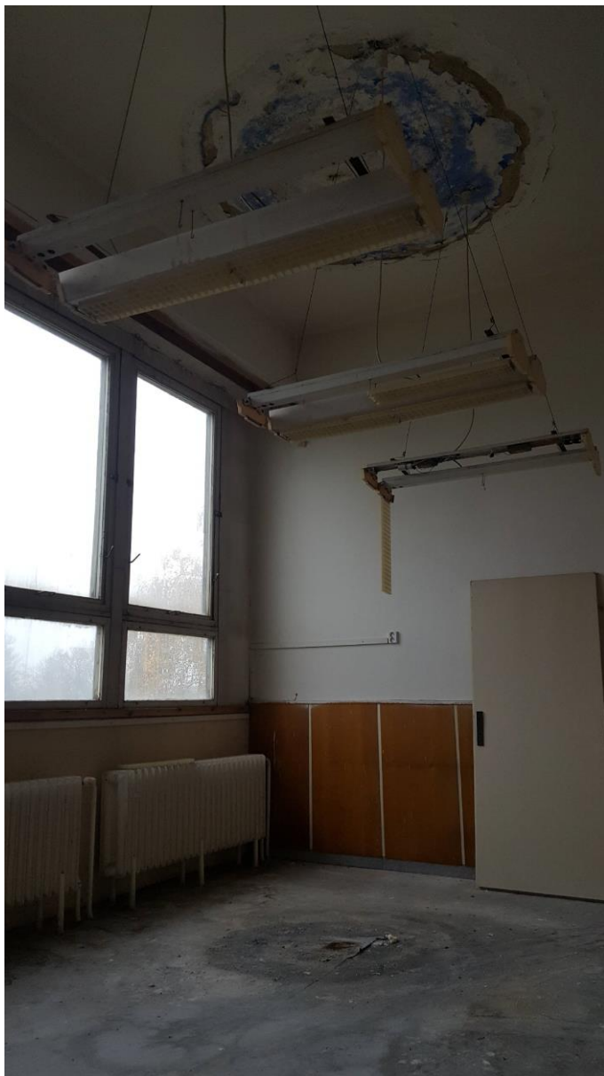
obr. č. 13 – mapy na spodním líci střešní konstrukce od zatečení
