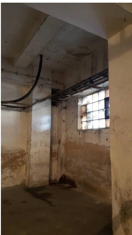
obr. č. 3 – pohled na zdivo suterénu, mapy po vzlínání vlhkosti
